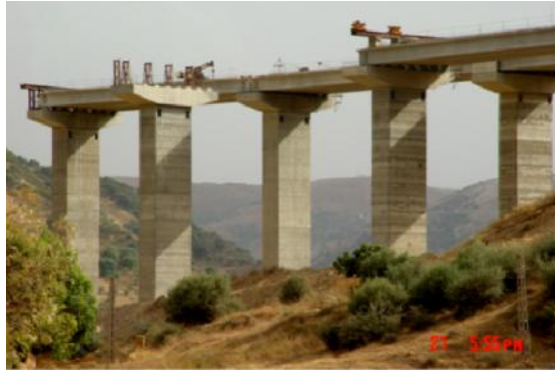
Fig. 1. Viaduc de Bouira (Algérie) en construction.
